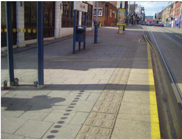
Fotoğraf 3.15. Tramvay durağında eliptik yüzey uygulaması örneği
