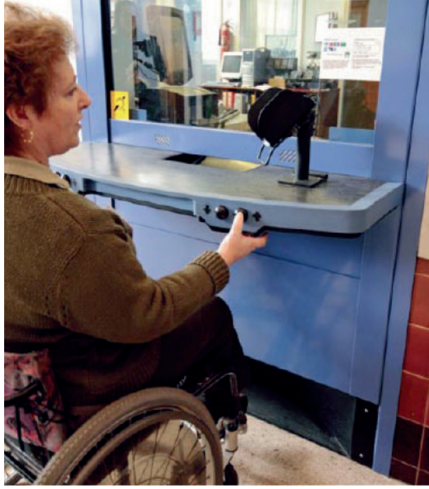
Fotoğraf 3.9. Alçaltılabilen bilet gişesi örneği (DfT, TScot, 2008)
