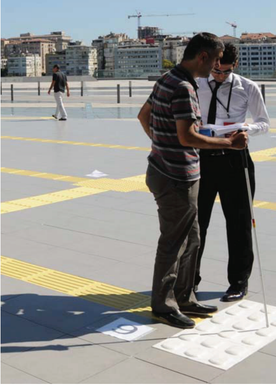
Fotoğraf 3.16. Hissedilebilir yüzey parkuru eliptik yüzey uygulaması
