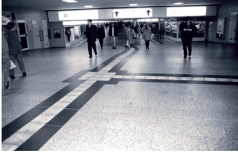
Fotoğraf 3.6. İstasyon ve terminallerde kılavuz iz ve yönlendirme ögesi örneđi (Naniopoulos, 1999)
