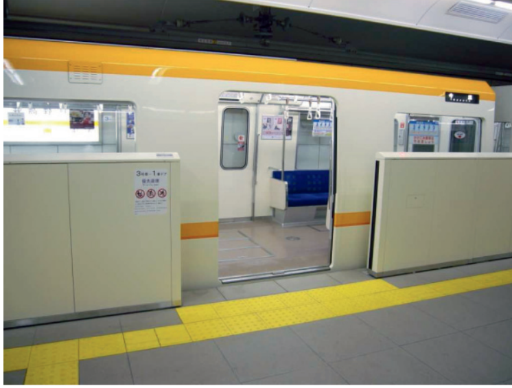
Fotoğraf 3.8. Metro vb. kentsel raylı sistem istasyonlarında duyum sanabilir yüzeylerle engellilerin yönlendirilmesi
